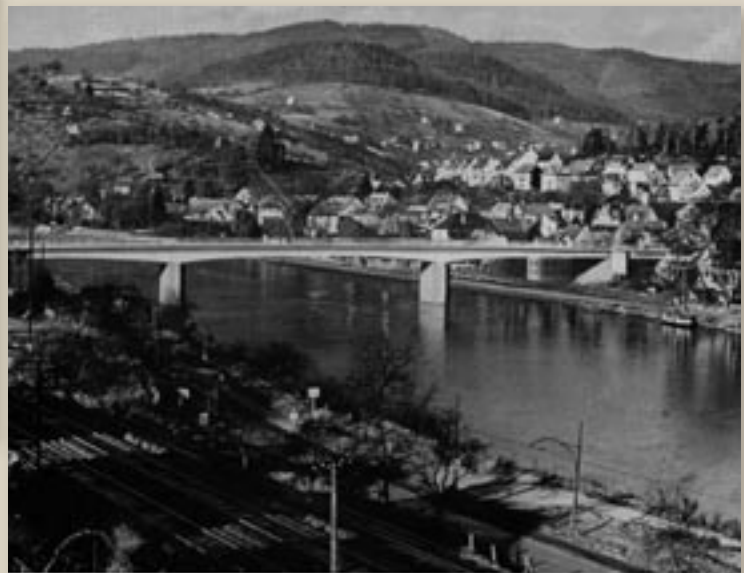
DIE NEUE NECKARBRÜCKE IN ZIEGELHAUSEN
